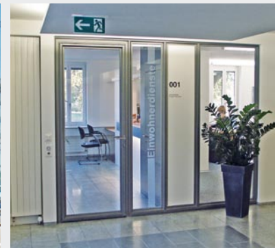
Brandschutztüre, Gemeindeverwaltung, Herrliberg
