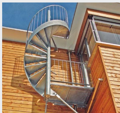
Ausbau Geschäftshaus, Adliswil
