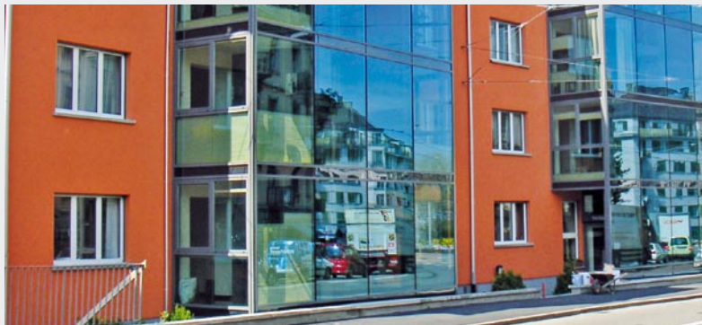
Glaskubus und Balkone, Alterswohnungen, Forchstrasse, Zürich
