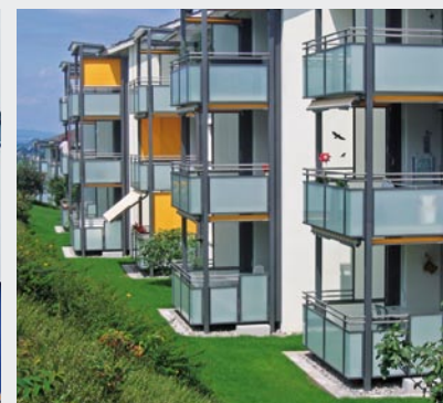
Balkone Mehrfamilienhaus, Wädenswil
