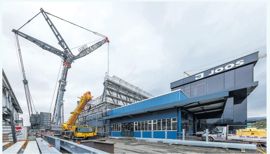
Die eingeschossige freitragende Hallen-Aufstockung des Produktionsstandortes der Joos Metall- und Stahlbau AG in Merenschwand. Foto: zvg
