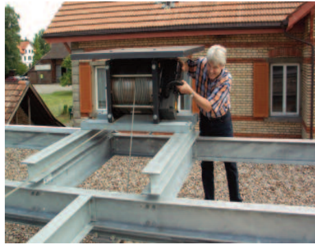
Peter Joos kontrolliert die Funktion des Trommelmotors
