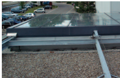
Seilzug, Umlenkrolle und Trommelmotor gewährleisten eine geräuscharme Bewegung.
