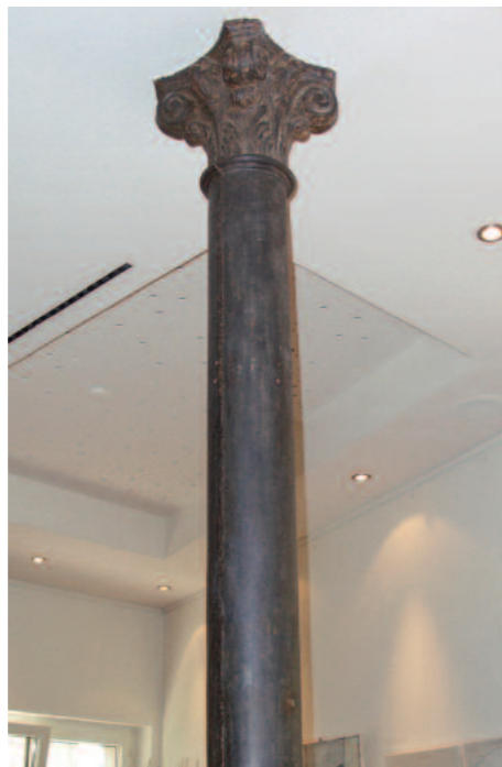
Über diese Säulen erfolgt die Kraftabtragung. Ce sont ces piliers qui supportent la charge de la construction.
