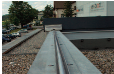
Auf vier Rollenpaaren lagernd, von innenliegenden Schienen geführt.
