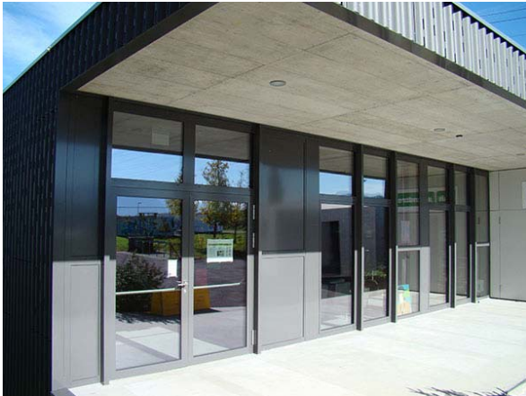
Der Haupteingang der neuen Jugendherberge Hünenberg: Metallbau von Joos
