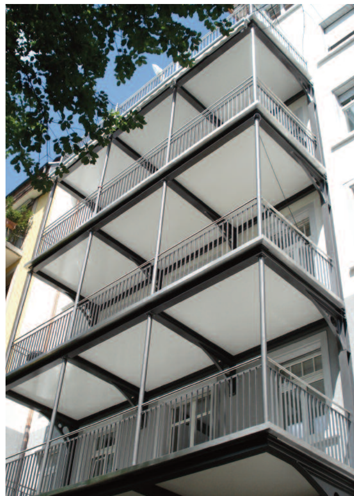
Mit Leichtbau-Bodenplatten lässt sich das Eigengewicht gegenüber Beton stark reduzieren.
